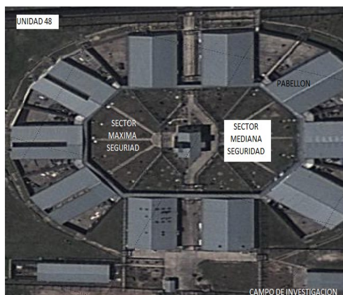
Figura I: Unidad 48 – Sector Mediana Seguridad - Pabellón cristiano
